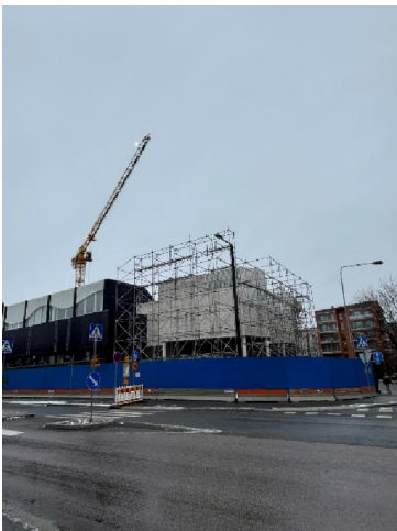
Kuva 1. Sääsuojuksen pystytys etenee hyvää tahtia.
