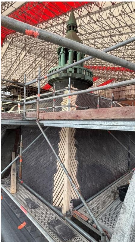
Kuva 5. Virastosiiven tornin liuskekiviasennusta.
