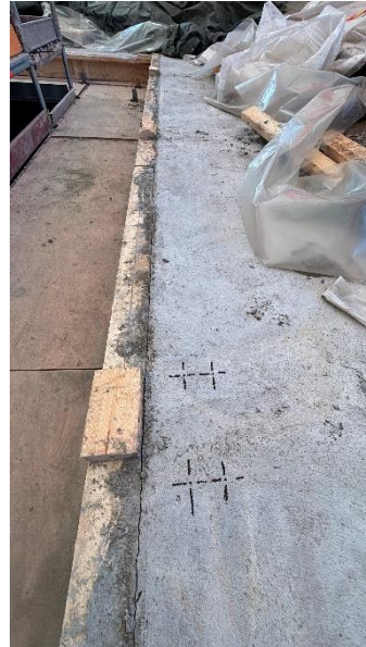
Kuva 3. Teräspilareiden paikkojen merkkausta.
