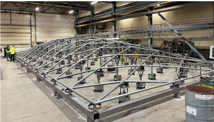
Kuva 4. Lasikaton teräsrunko verstaalla. Kuva, Teräselementti Oy.
