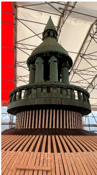
Kuva 1. Lanterniini korjauksen jälkeen.
