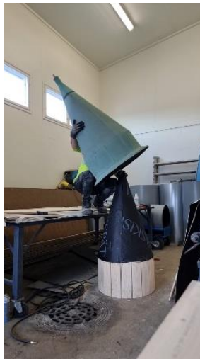
Kuvat 2–4. Lanterniinin korjausta. (Kuvat, Suomen Vaskiseipät Oy)
