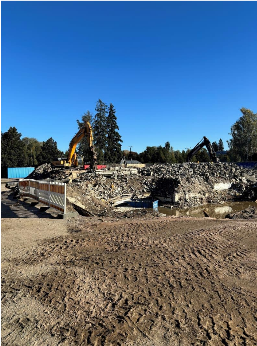
Kuva 3. Poliisitalon betonijätteen erottelu ja pulverointi käynnissä.
