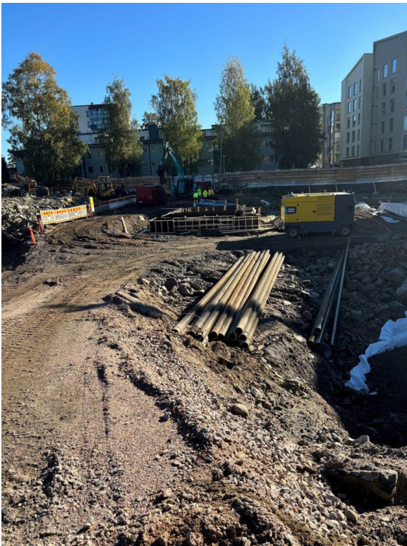
Kuva 1 ja 2. Perustus- ja paalutustyöt käynnissä.
