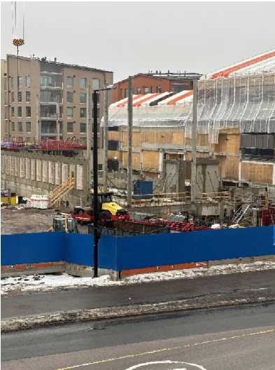
Kuva 1. Pääsisäänkäynnin pilarit ovat valettu.
