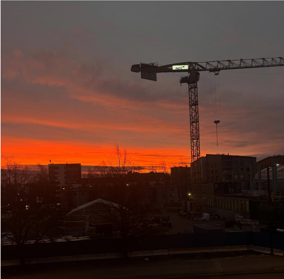
Kuva 1. Torninosturi on näkyvä maamerkki Tikkurilassa Oikeustalon työmaalla.
