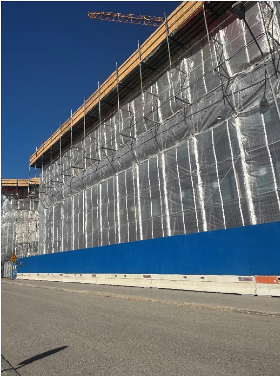
Kuva 1 ja 2. Kohteen sääsuojat ovat luoneet hyvät työskentelyolosuhteet työmaalle.
