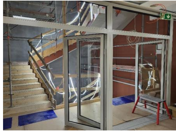
Kuva Teräslasioviasennusta
