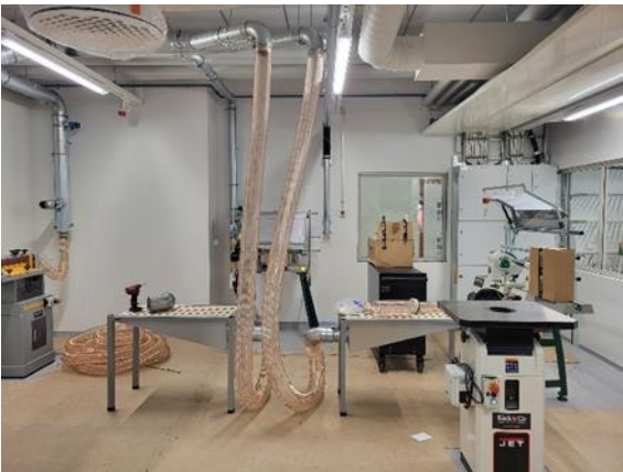
Kuva Purunpoiston kytkentätöitä
