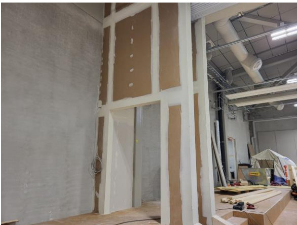
Kuva Katsomon väliseinien tasoitus- ja maalaustyöt käynnissä
