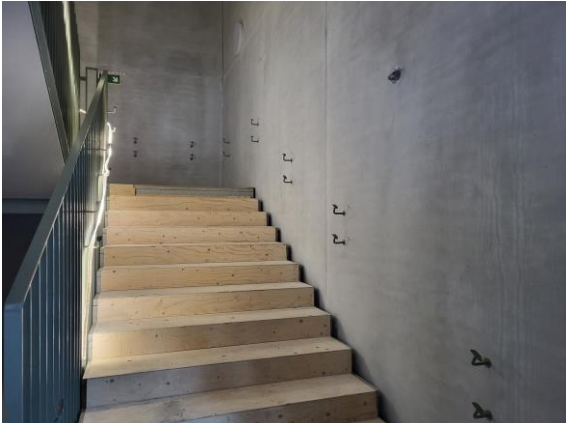
Kuva Käsijohteiden asennukset käynnissä
