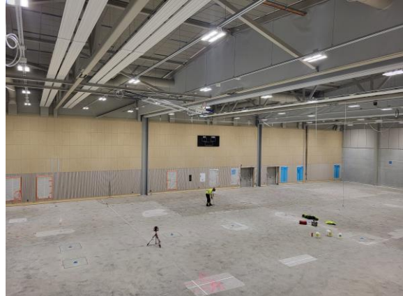
Kuva Liikuntasalin valmista seinää ja plaanovalmisteluja
