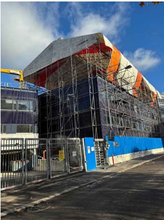
Kuva 1 ja 2. T-lohkon sääsuojien asennukset käynnissä.
