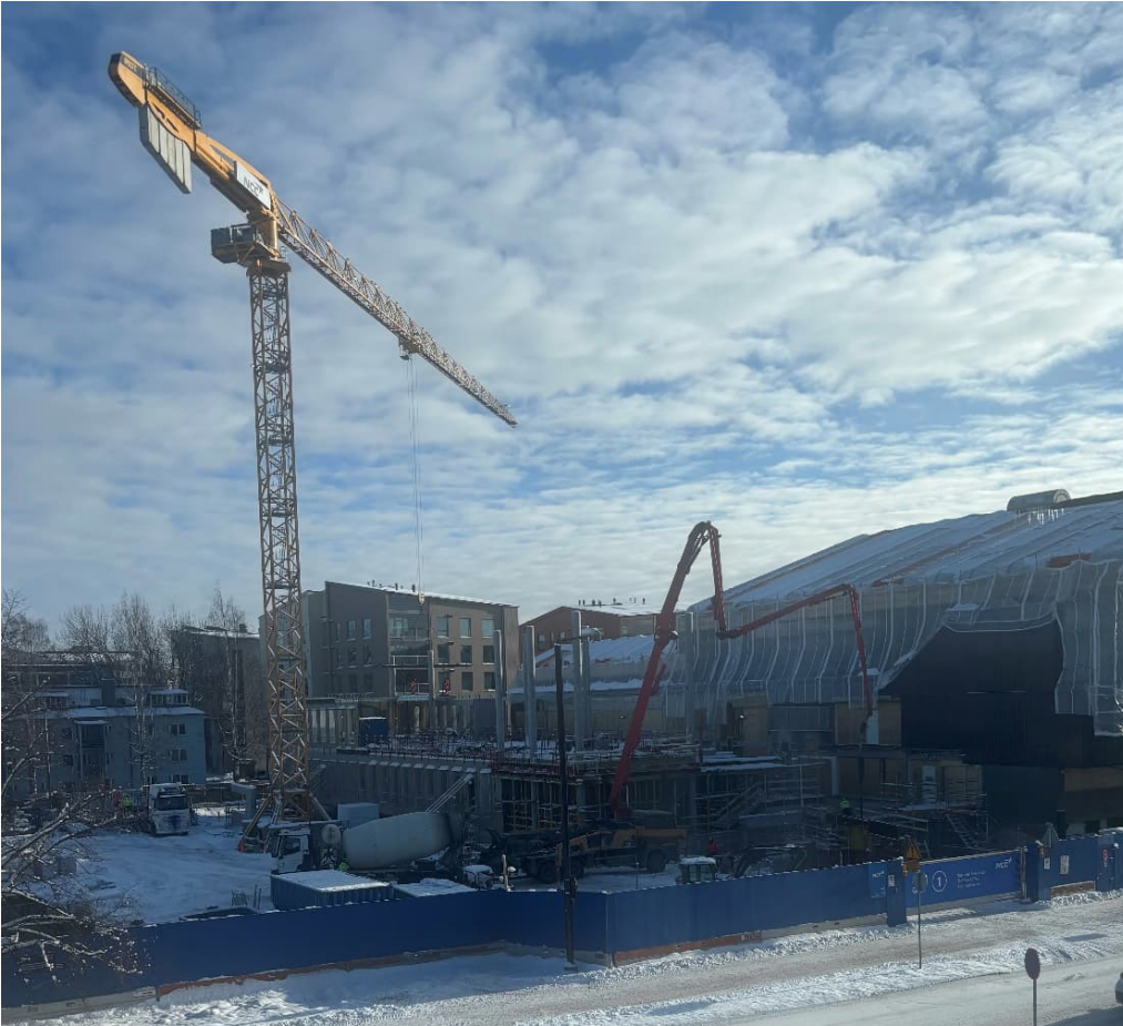
Kuva 1. Uudisosan elementeistä asennettuna yli puolet.
