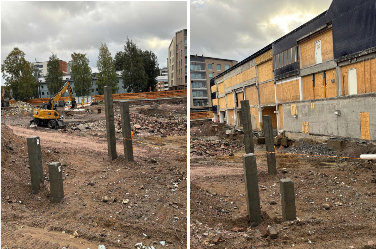
Kuva 1 ja 2. Ensimmäiset paalut paalutettu uudisosalle.
