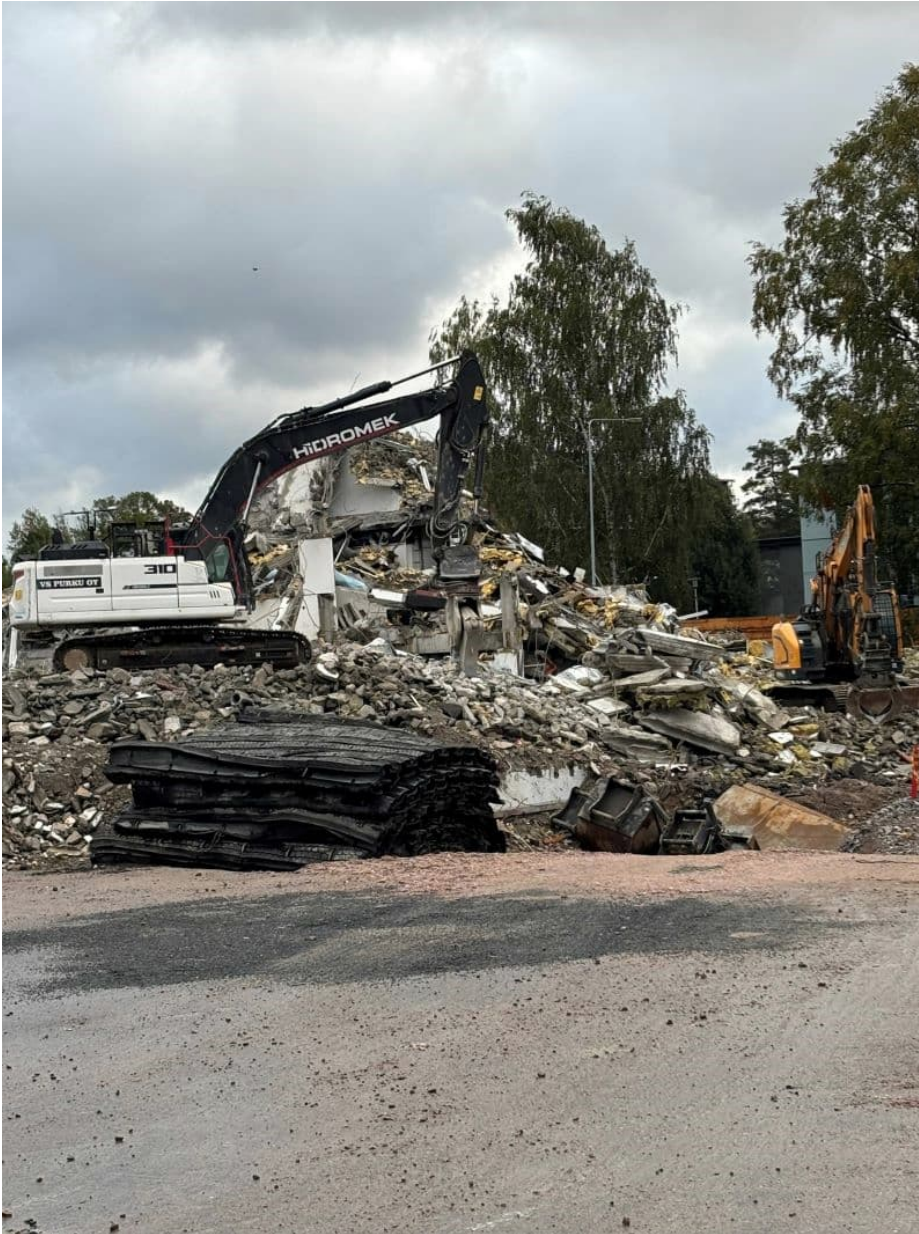
Kuva 3. Poliisitalon kaikki rakennukset purettu maan tasalle.
