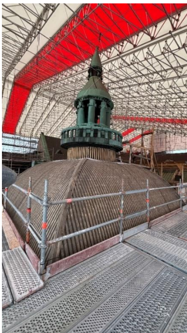
Kuva 2-4. Virastosiiven tornin vanhat liuskekivet poistettu ja lanterniinin kunnostus aloitettu.
