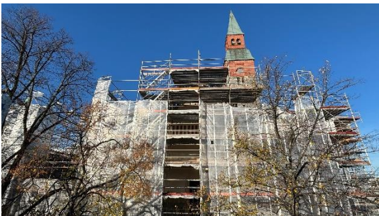
Kuva 8–9. Säesuojan purku aloitettu lohkolla 1 ja valmista julkisivua alkaa paljastua telien takaa.
