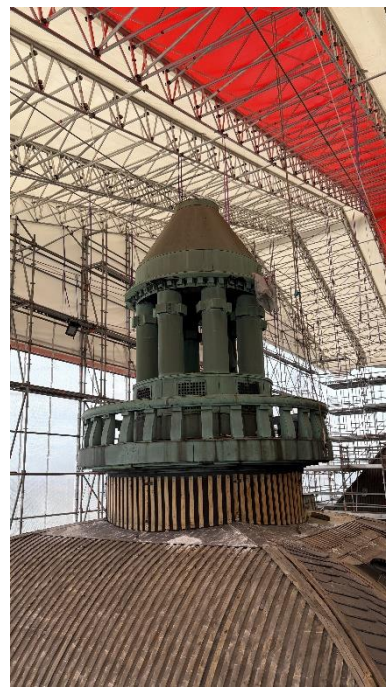
Kuva 2-4. Virastosiiven tornin vanhat liuskekivet poistettu ja lanterniinin kunnostus aloitettu.
