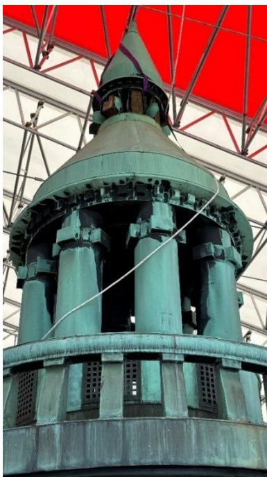
Kuva 2-4. Virastosiiven tornin vanhat liuskekivet poistettu ja lanterniinin kunnostus aloitettu.
