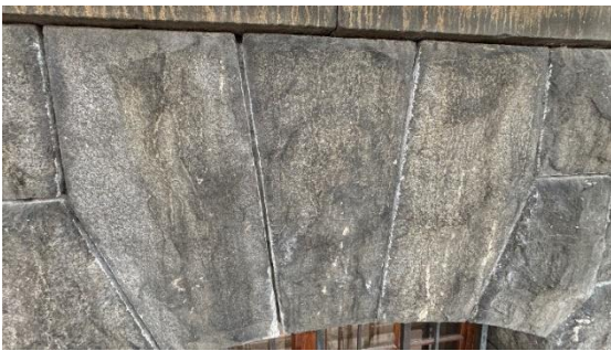
Kuva 6. Kivisaumausten uusimista Virastosiiven länsijulkisivulla.
