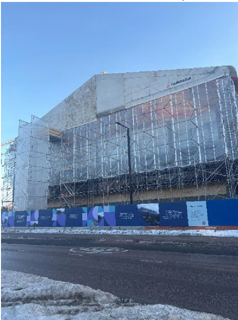
Kuva 1. Sääsuojan asennustyöt ovat valmistuneet.
