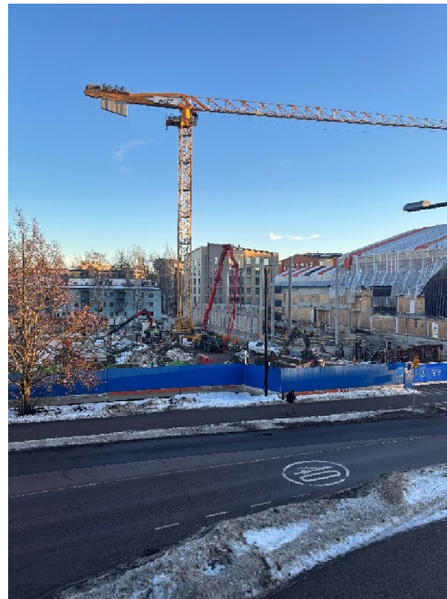
Kuva 2. Elementtiasennukset etenevät laajennusosalla.
