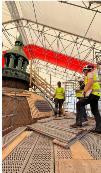
Kuva 4. Rondellin ladontatarkastus.
