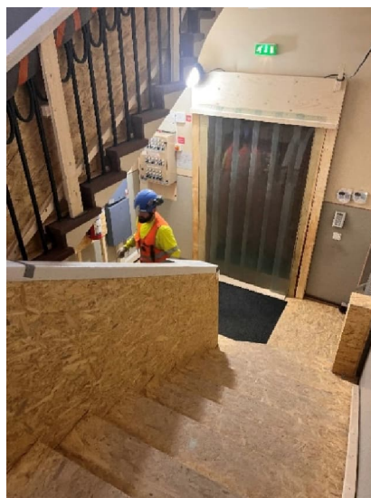
Kuva 1-3. Aamujumppaa ja poistumisharjoituksia.
