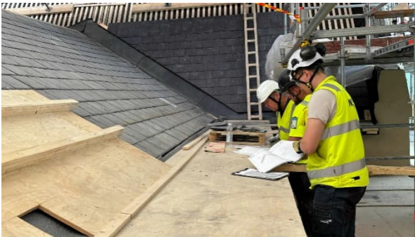
Kuva 5. Työpiirustusten tutkimista katolla.
