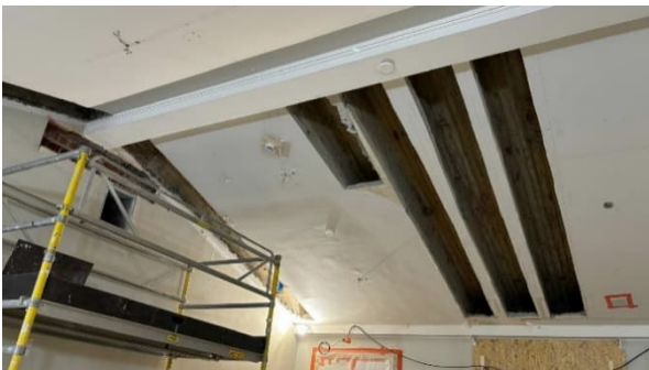
Kuva 7. Hormien reittejä yläpohjassa.
