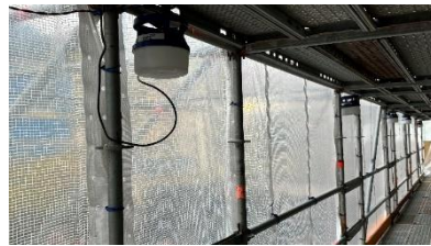
Kuva 6. Telineiden valaistuksen asennusta.
