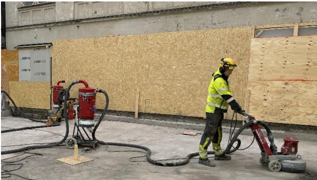
Kuva 5. Halkopihan lattian pintalaatan poistoa.
