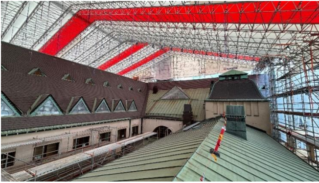
Kuva 3. Sääsuoja kattojen yllä.
