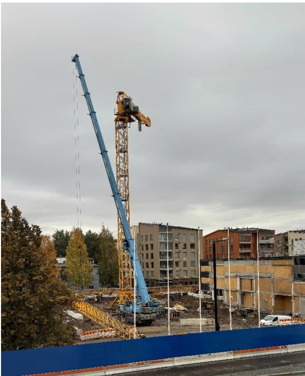
Kuva 1 ja 2. Torninosturin pystytys käynnissä.
