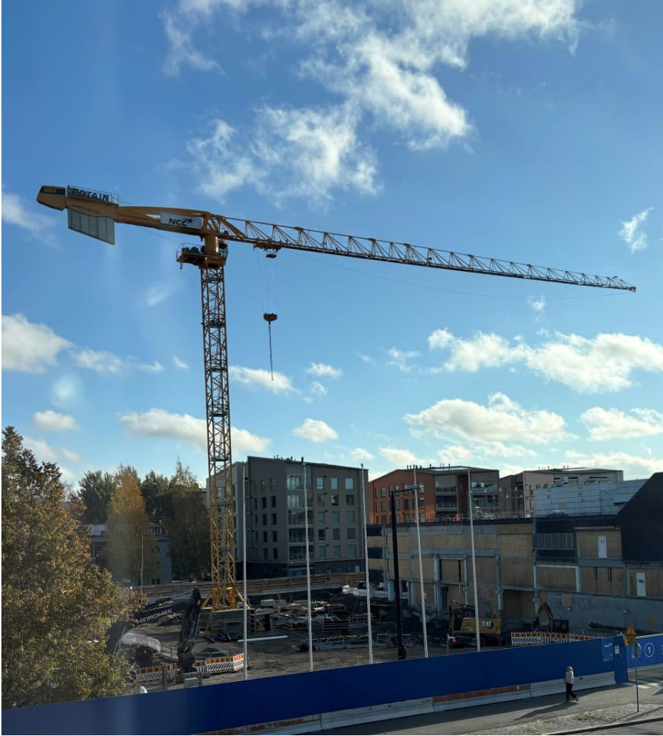
Kuva 3. Torninosturinkuljettaja työn touhussa työmaalla.
