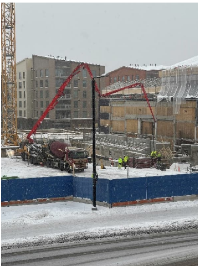
Kuva 1. Laajennusosan valut jatkuivat heti vuoden alussa.
