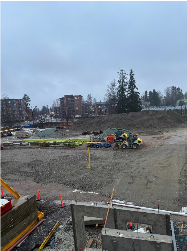
Kuva 3. Mara-mursketta levitetty tontin keski- ja pohjoisosalle.
