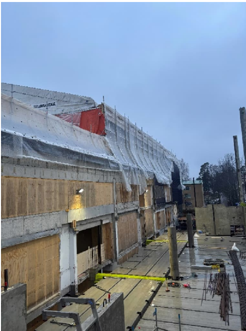
Kuva 1 ja 2. Ontelolaatat asennettu laajennusosan 1. ja 2. kerroksille.
