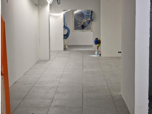
Kuva B-lohkon 2 kerroksen lattiaaatoitustyöt käynnissä
