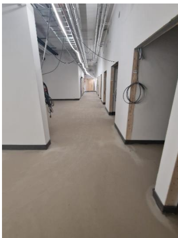
Kuva C-lohkon toisen kerroksen plaanoitettua käytävää
