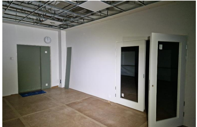
Kuva A-lohkon mallihuoneiden oviaisennuksia
