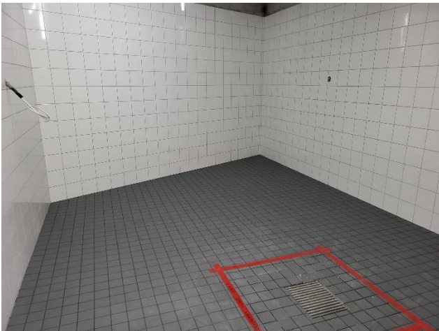
Kuva B-lohko 2. kerros siivoushuoneen laatoitusta
