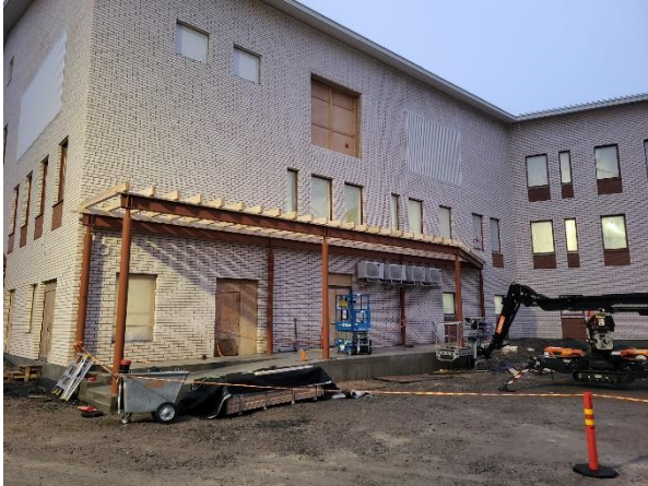
Kuva B-lohko lastauslaiturin katoksen runkoa
