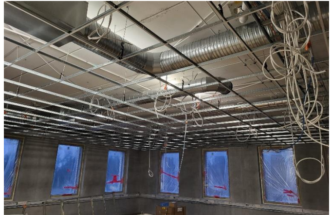
Kuva A-lohko tekstiilityöluokan alakattorunkoa
