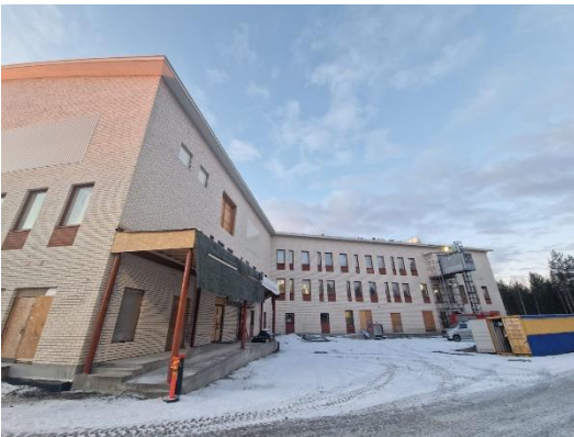
Kuva A- ja B-lohkojen julkisivua
