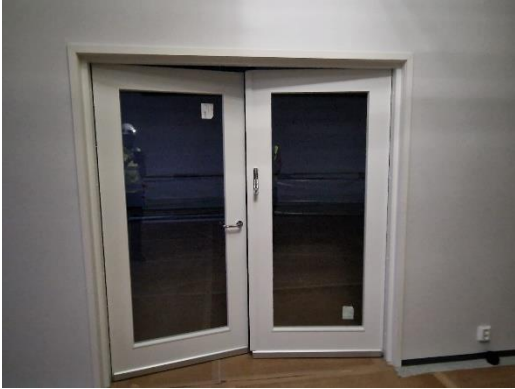
Kuva A-lohkon mallihuoneen välioviasennusta
