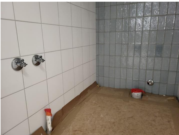
Kuva B-lohko vesikalusteasennuksia
