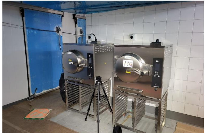
Kuva B-lohkon keittiölaiteasennuksia
