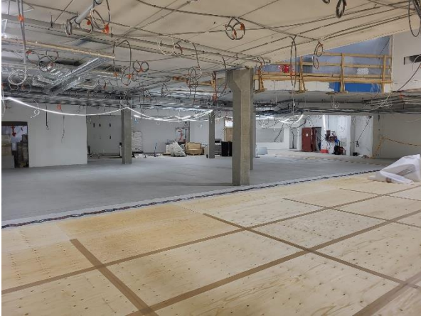
Kuva B-lohkon ruokailuauilan laatoitusta ja suojausta
