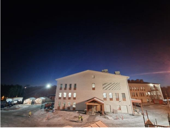
Kuva työmaan pihalta
