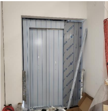
kuva hisiasennus jatkuu
