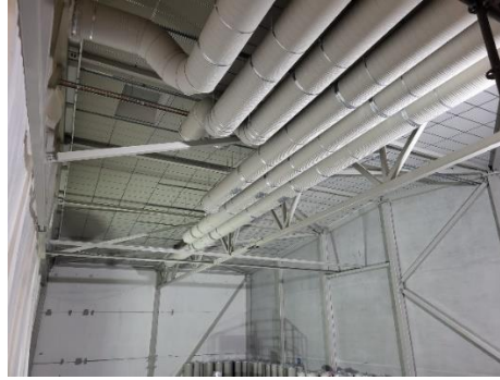
Kuva liikuntasalin IV- asennuksista
