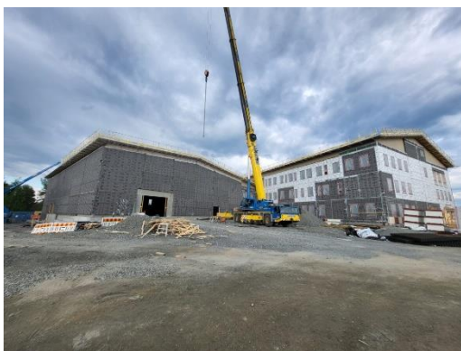
Kuva C- lohkon kattoelementtiasennuksista
