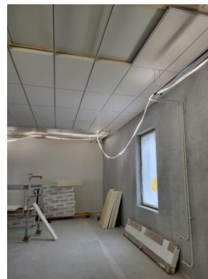
Kuva A- lohkon alakattoasennustöistä
