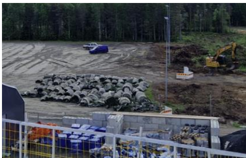
Kuva Lähiliikuntakentän työt käynnissä
