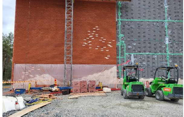
Kuva C- lohko virikeseinän muuraustöitä
