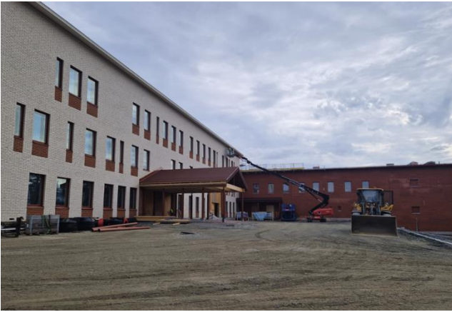
Kuva Eteläpuolen pihan maarakennustöitä
