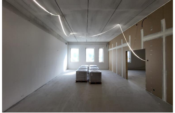
Kuva B lohko 3. kerros tasoite- ja maalaustyöt
