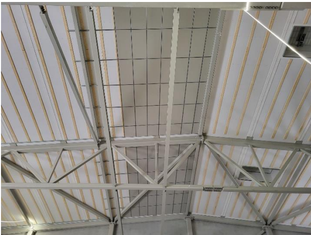
Kuva Liikuntasalin alakattotyöt käynnissä
