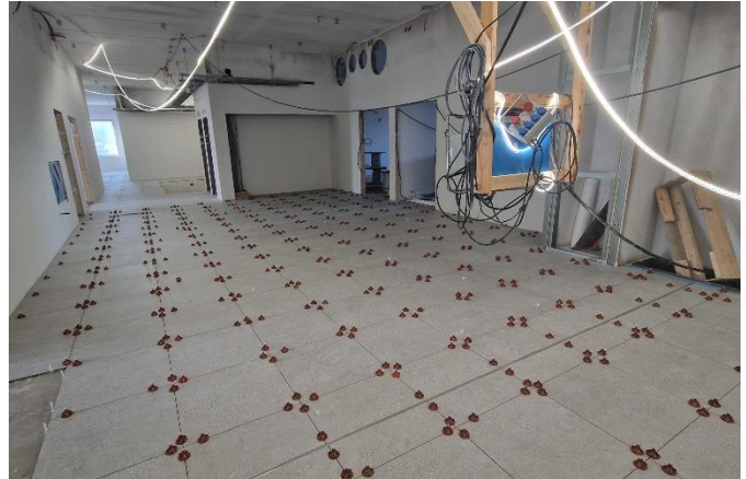
Kuva A lohko 3. kerros lattialaatoitustyöt
