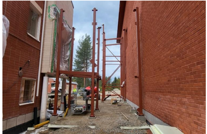
Kuva yhdyskäytävän teräsrunkoasennuksista
