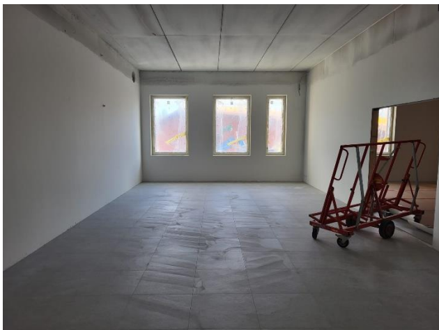
Kuva lattialaatoitustyöt etenevät B-lohkolla
