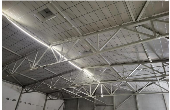
Kuva liikuntasalin katon akustiikkalevyasennuksia
