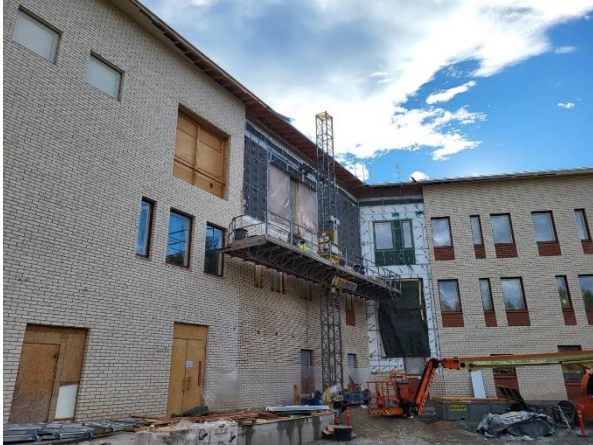
Kuva julkisivun muuraustöitä B-lohkolla
