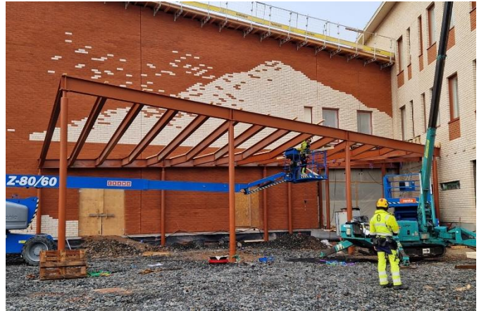
Kuva Pääsisäänkäynnin teräsrunkoasennuksia
