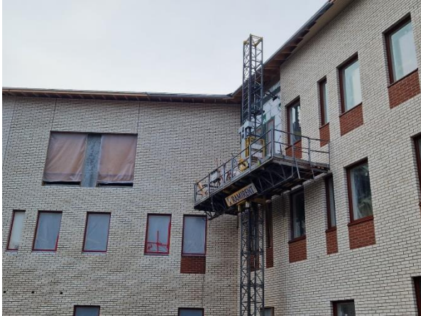
Kuva julkisivun muuraustyöt valmistuvat
