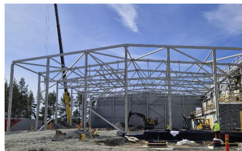
Kuva C-lohkon liikuntahallin työt etenevät
