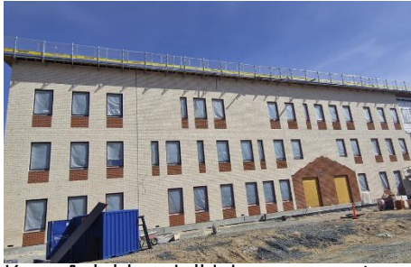
Kuva A-lohkon julkisivumuurausta
