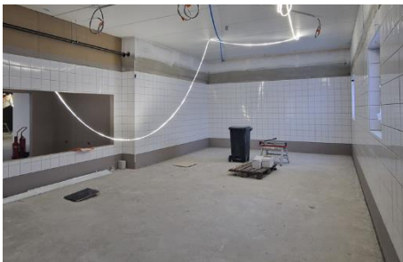
Kuva B-lohkon seinälaatoitustöistä
