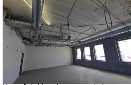
Kuva A-lohkon iv- asennuksia
