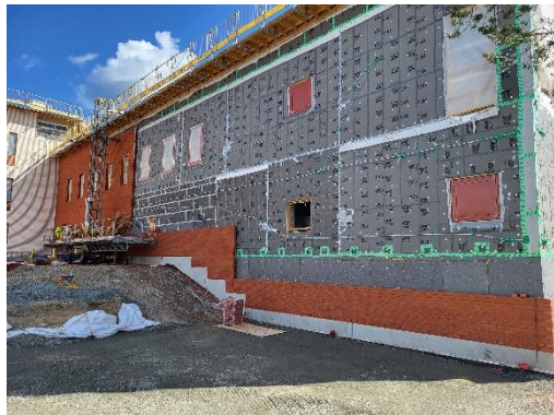
Kuva C- lohkon julkisivumuurauksesta
