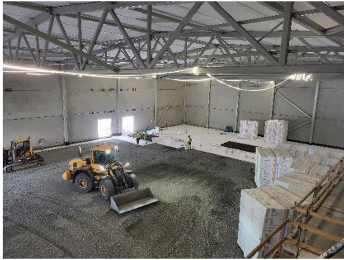
Kuva C- lohkon maanvaraisen lattian töistä
