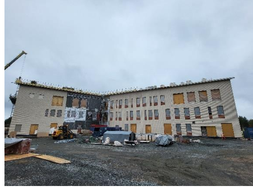
Kuva B-A lohkojen julkisivumuurauksista
