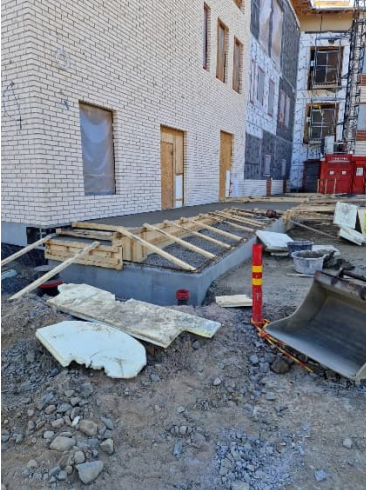
Kuumennuskeittien lastauslaiturin valu
