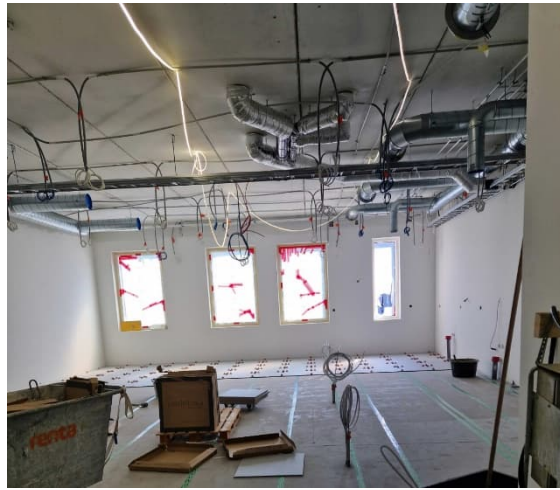
B1 lattialaatoitus käynnissä
