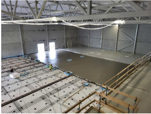
Kuva C-lohkon liikuntasalin työt etenevät
