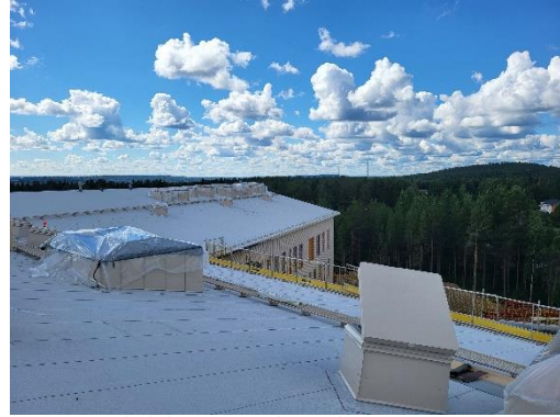
Kuva A-lohkon vesikatolta
