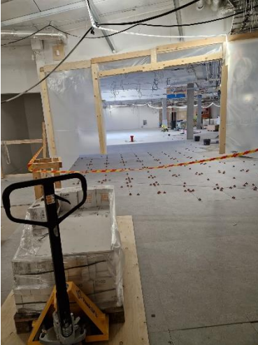
Ruokalan laatoitustyöt käynnissä
