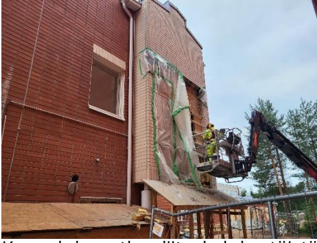
Kuva yhdysputken liitoskohdan töistä
