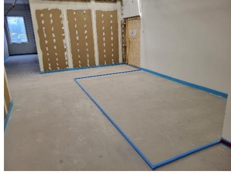
Kuva A- lohkon plaanovalmisteluja
