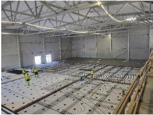
Kuva liikuntasalin maanvaraisen lattian töistä
