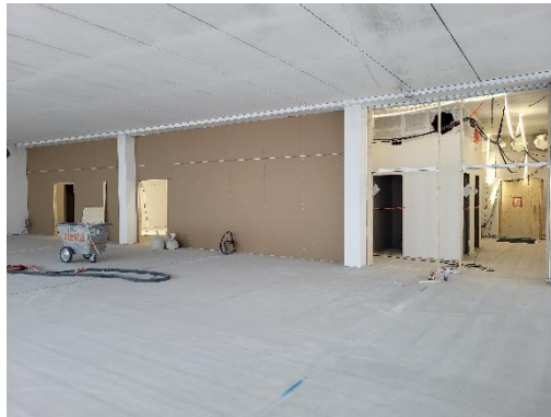
Kuva B-lohkon 3. kerroksen väliseinätöistä
