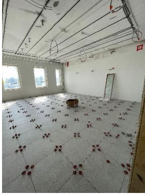
Kuva Mallihuoneiden laatoitustyöt
