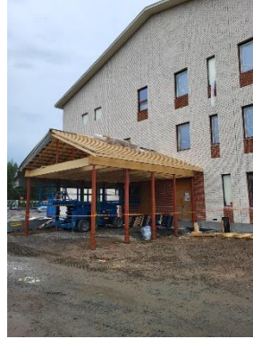
Kuva Katosten pystytystyöt
