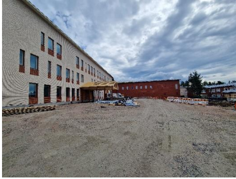
Kuva A-lohkon edustan pihatyöt käynnissä
