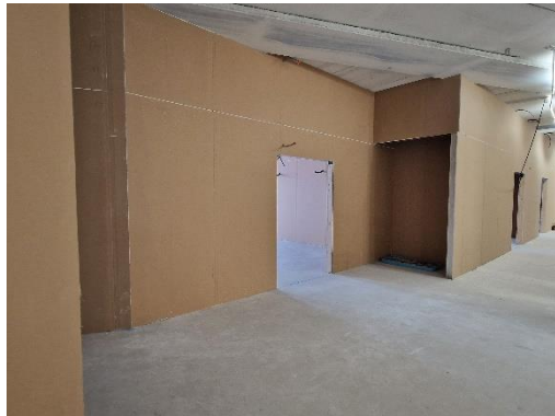
Kuva B-lohkon 3 krs väliseiniä
