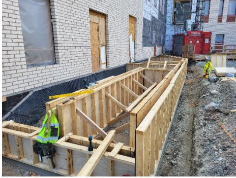
Kuva B- lohkon lastauslaiturin muottitöistä
