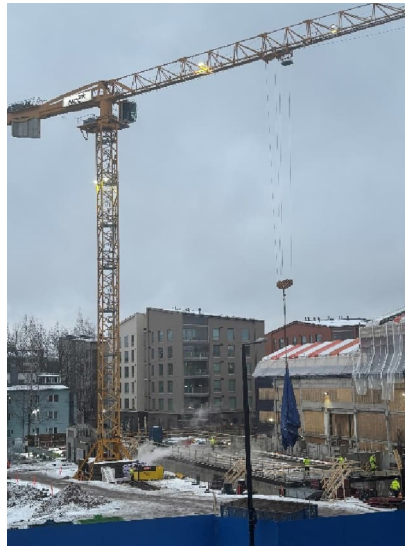
Kuva 2. Torninosturi työn touhussa.
