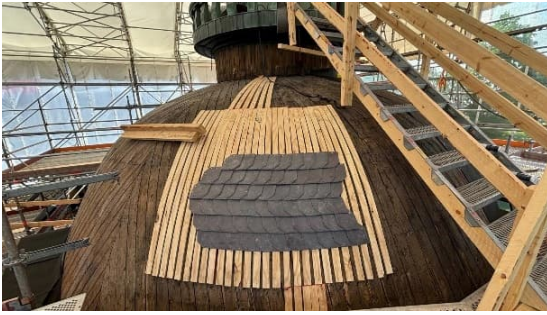
Kuva 6-7. Erilaisia liuskekivien muotoja katolla.
