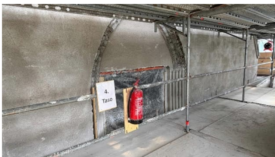
Kuva 4. Tartuntarappaus lohkon 1 eteläjulkisivulla.
