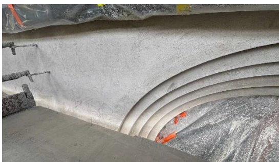
Kuva 5. Täyttörappaus tehty lohkon 1 itäjulkisivulla.
