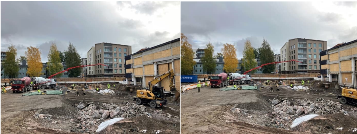
Kuva 1 ja 2. Uudisosan ensimmäisten perustusten valu käynnissä.
