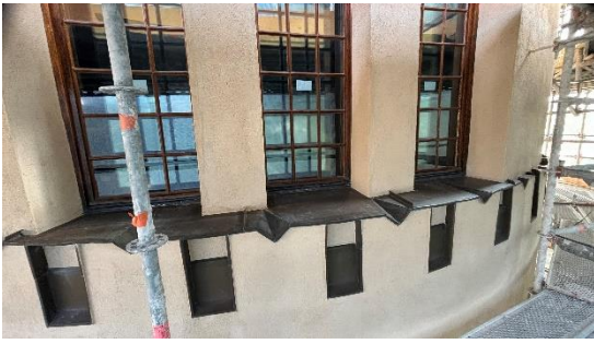
Kuva 7–8. Julkisivun maalaus, pellitykset ja katon liuskekettyminen valmiina loholla 1.
