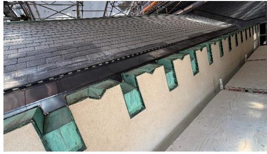
Kuva 7–8. Julkisivun maalaus, pellitykset ja katon liuskekettyminen valmiina loholla 1.
