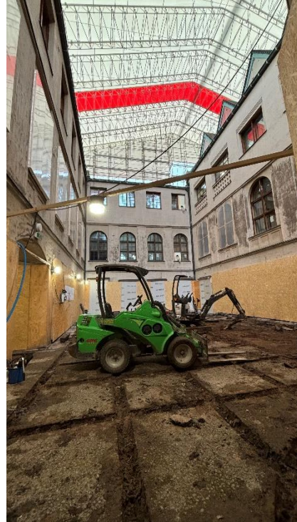
Kuva 10. Halkopihan lattiaa purkutyöt aloitettu.
